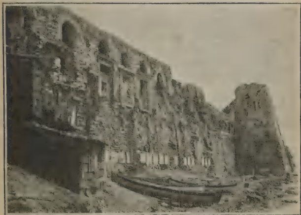
FIG. 35. « Maison de Justinien ». Façade sur la mer.
